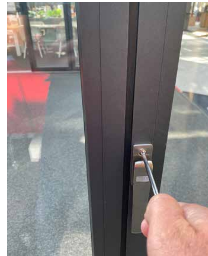
Nalopen van hang- en sluitwerk.
